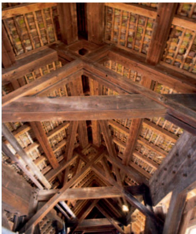
Feinste Zimmermannsarbeit: das Dachgebälk der Säckinger Brücke.
