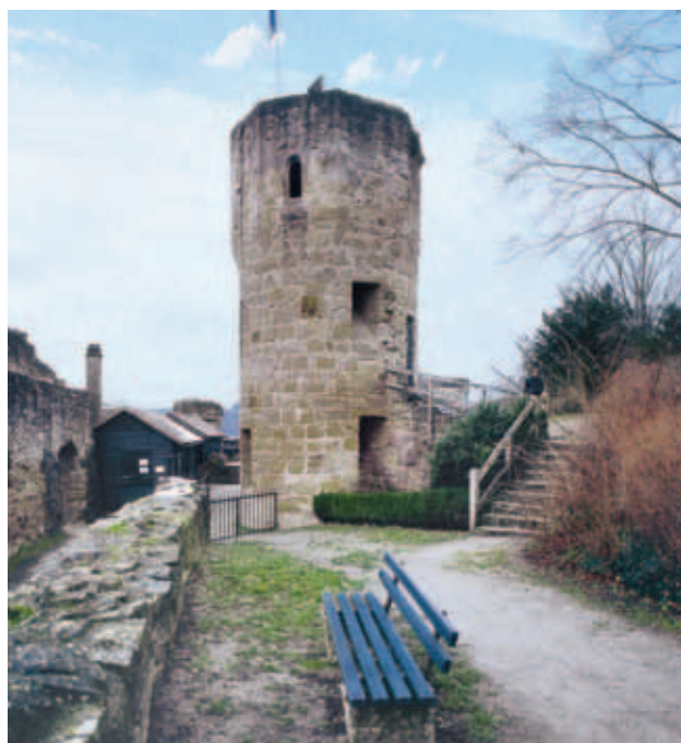
Eine Landmarke: der zur Burg gehörende, alles überragende Geschützturm.
