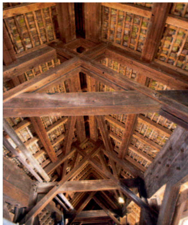
Feinste Zimmermannsarbeit: das Dachgebälk der Säckinger Brücke.
