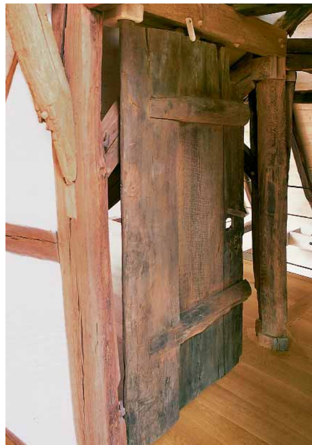
Originales Fachwerk und Türe der ersten Bauphase.
