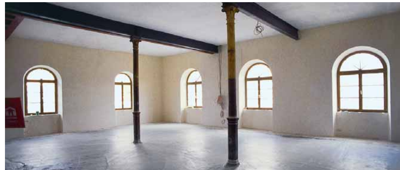
Von späteren Einbauten befreit, lichte Halle im Ostteil.
