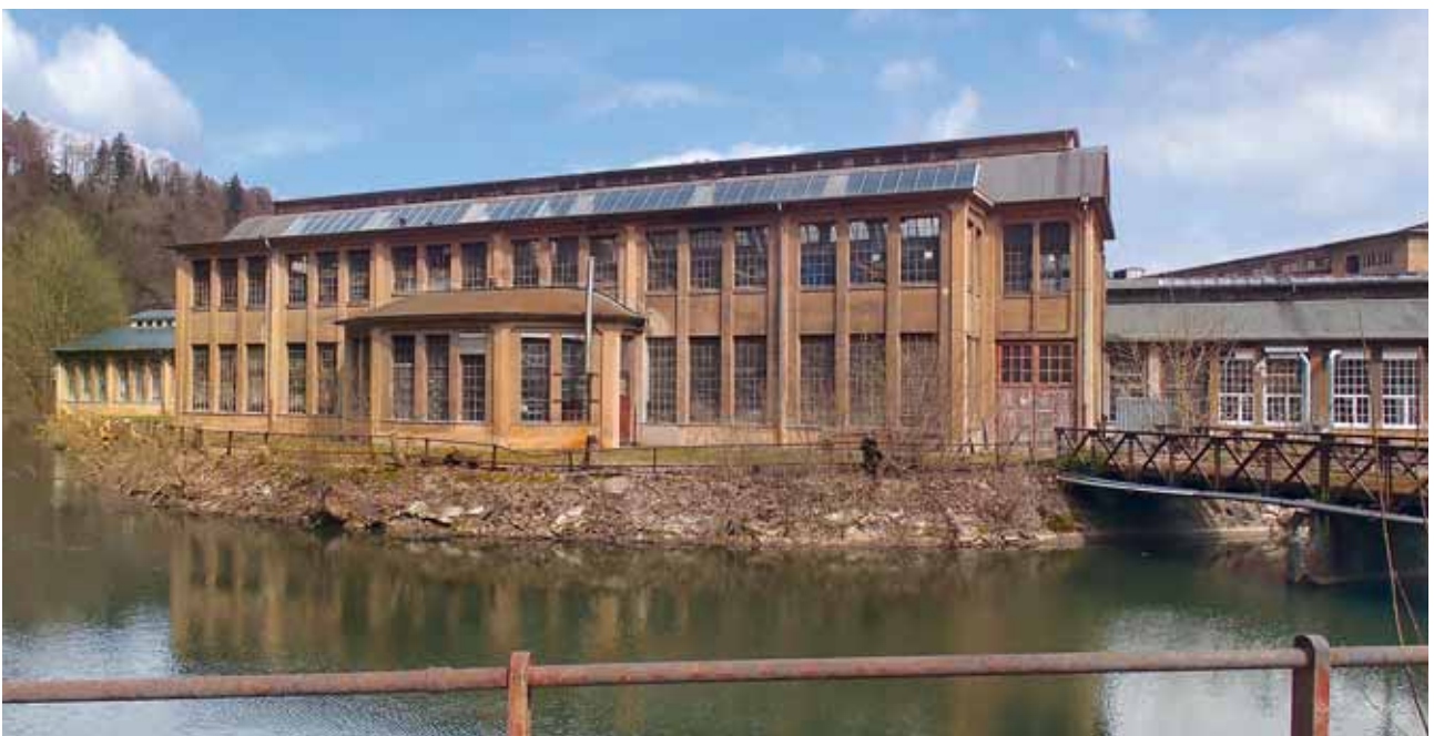
Filigran gegliedert ist die mächtige Stahlbetonkonstruktion des Werkstattbaus am Neckar.
