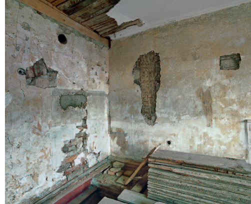
Innen sind die schwierigen Renovierungsarbeiten in vollem Gange.
