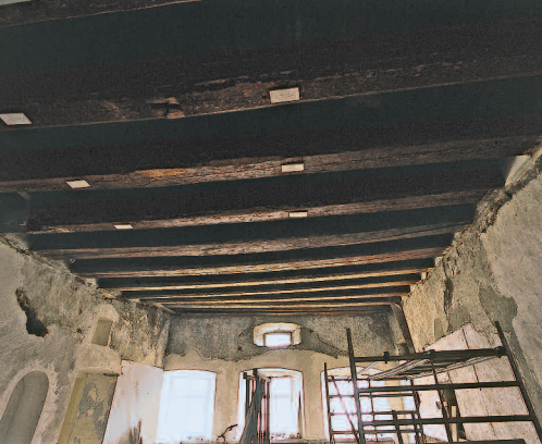
Eine ursprüngliche Balken- und Bohlendecke kann erhalten werden.
