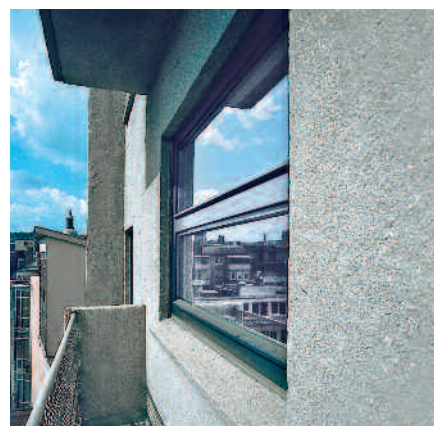
Ein Prototyp der neuen/alten vertikal geteilten Fenster im Zeitungsturm.
