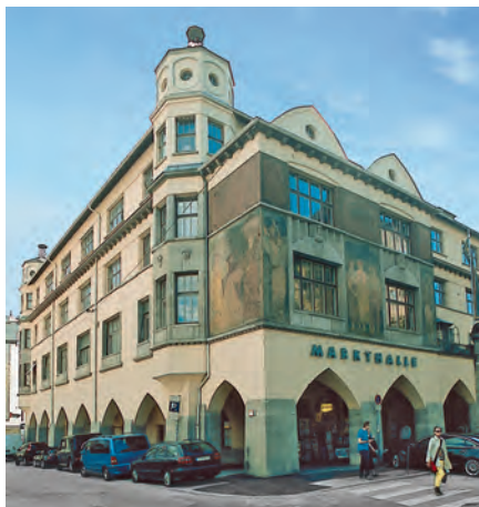
Die Malereien an der Außenseite der Markthalle werden restauriert.
