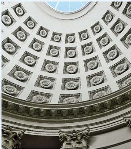
Kassetten in der Decke des Mausoleums auf dem Rotenberg bei Stuttgart.
