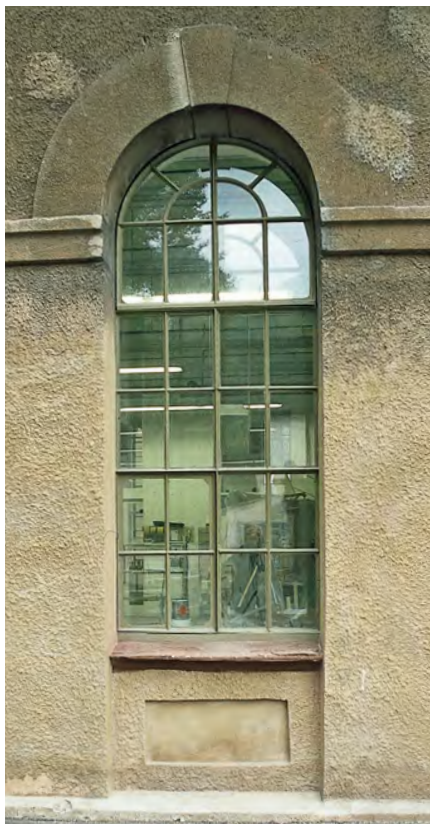
Charakteristisch für das Pumpenhaus sind filigrane rundbogige Sprossenfenster.
