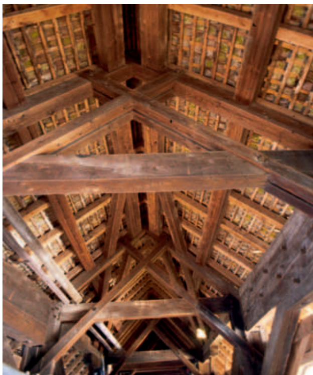
Feinste Zimmermannsarbeit: das Dachgebälk der Säckinger Brücke.
