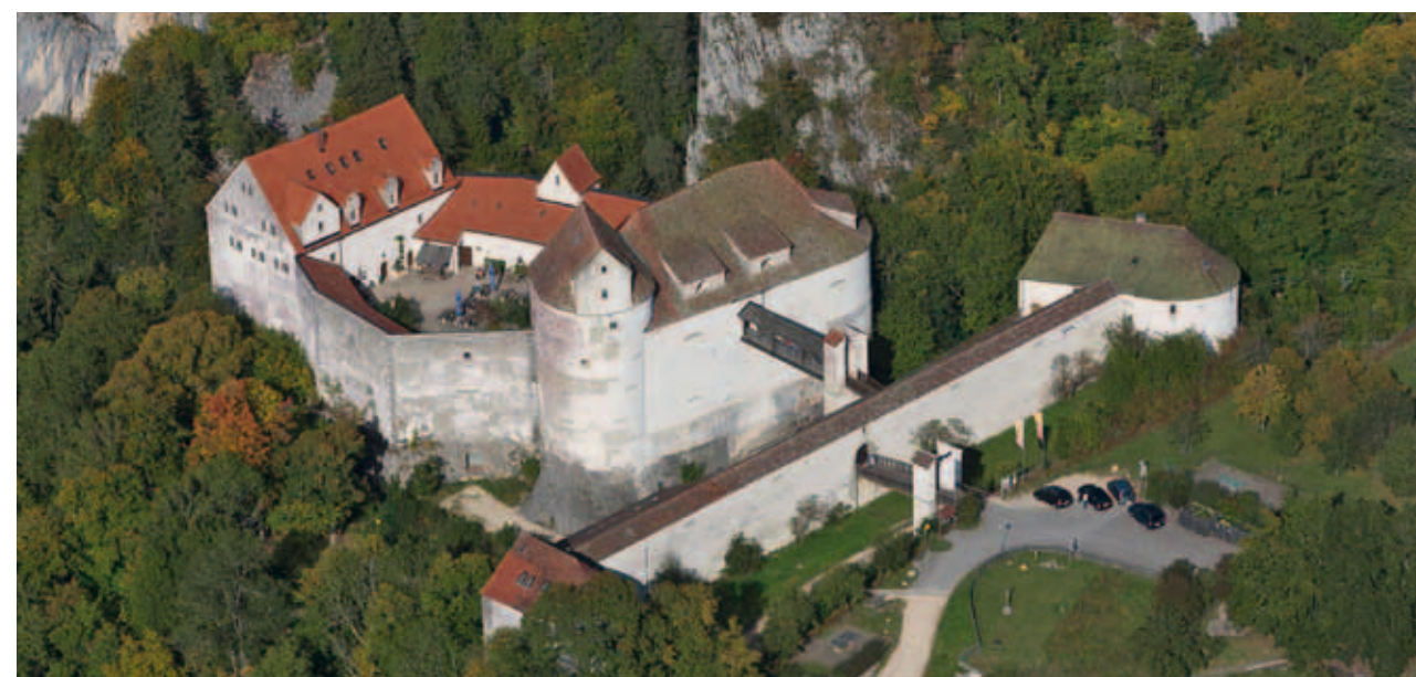
Das Gebäudeensemble der Burg Wildenstein. Die Renaissancemalereien befinden sich im Bau ganz links.
