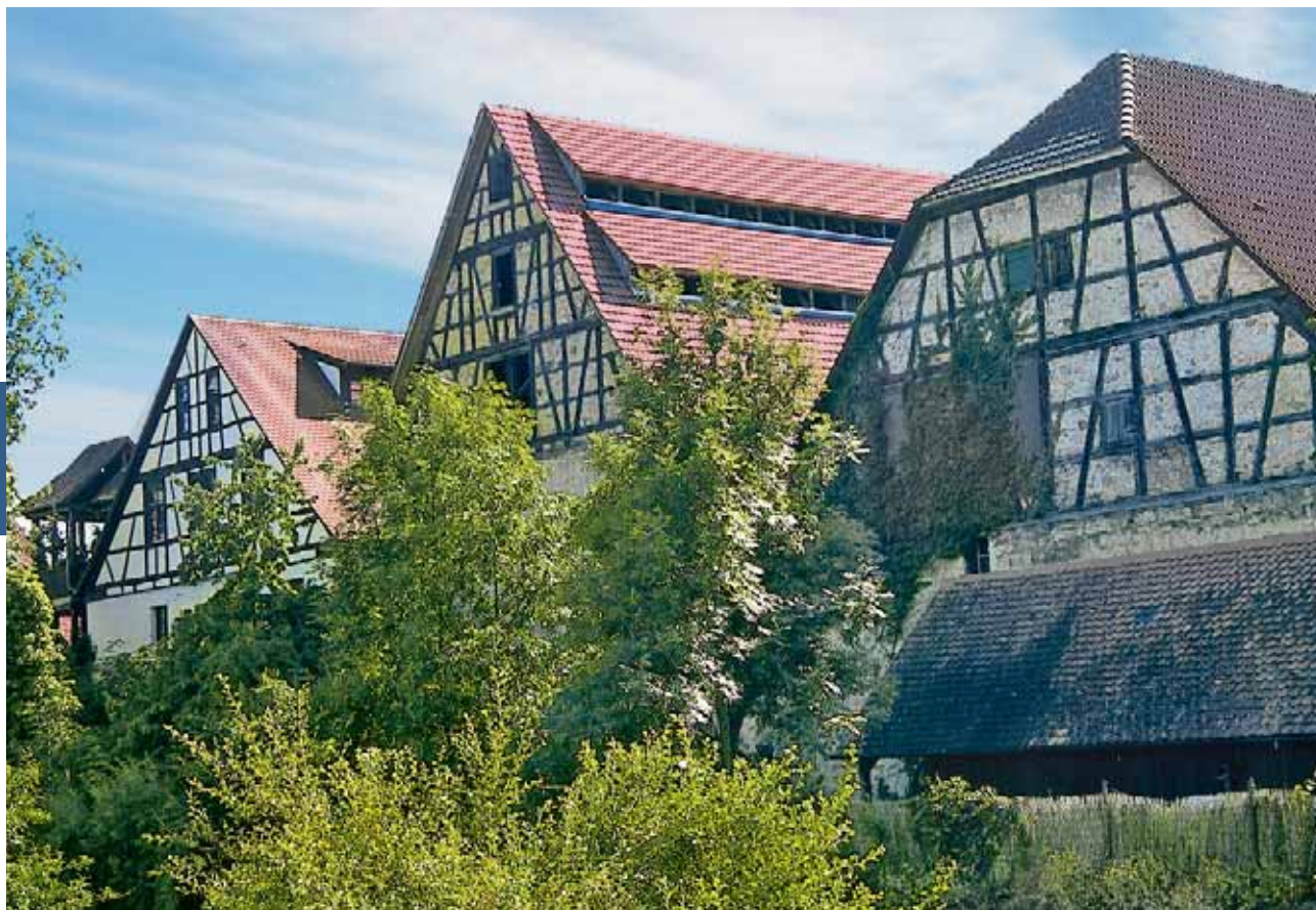
Rottenburg, der Amannhof (Mitte) und Nebengebäude an der Stadtmauer.
