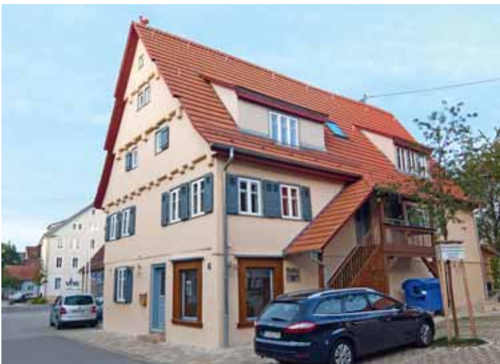
Dank des „Fördervereins Ortskern Betzingen“ ist auch das Bauernhaus neben der ehemaligen Zehntscheuer „wieder-erstanden“.
