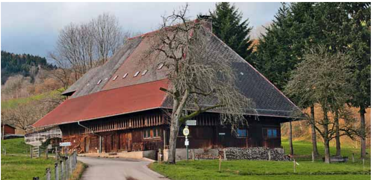
Der Fußehof: ein Riese aus Holz mit mächtigem Walmdach.
