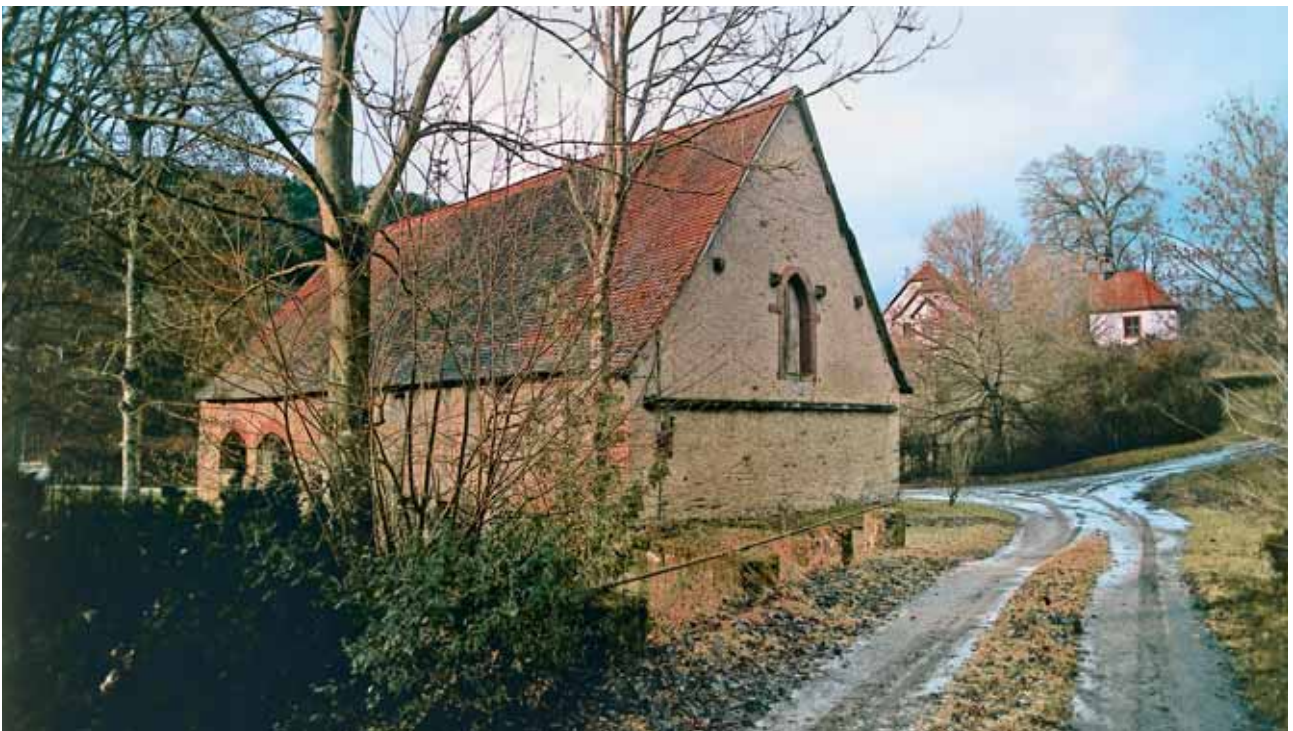
Ein mächtiger „Monolith“ am Wegesrand, das 1450 entstandene Wirtschafts- und Stallgebäude des Hofguts Breitenau.
