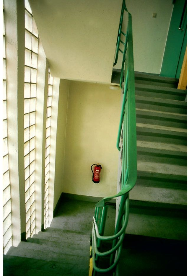
Ein elegantes Geländer und Glasbausteine gestalten das Treppenhaus.
