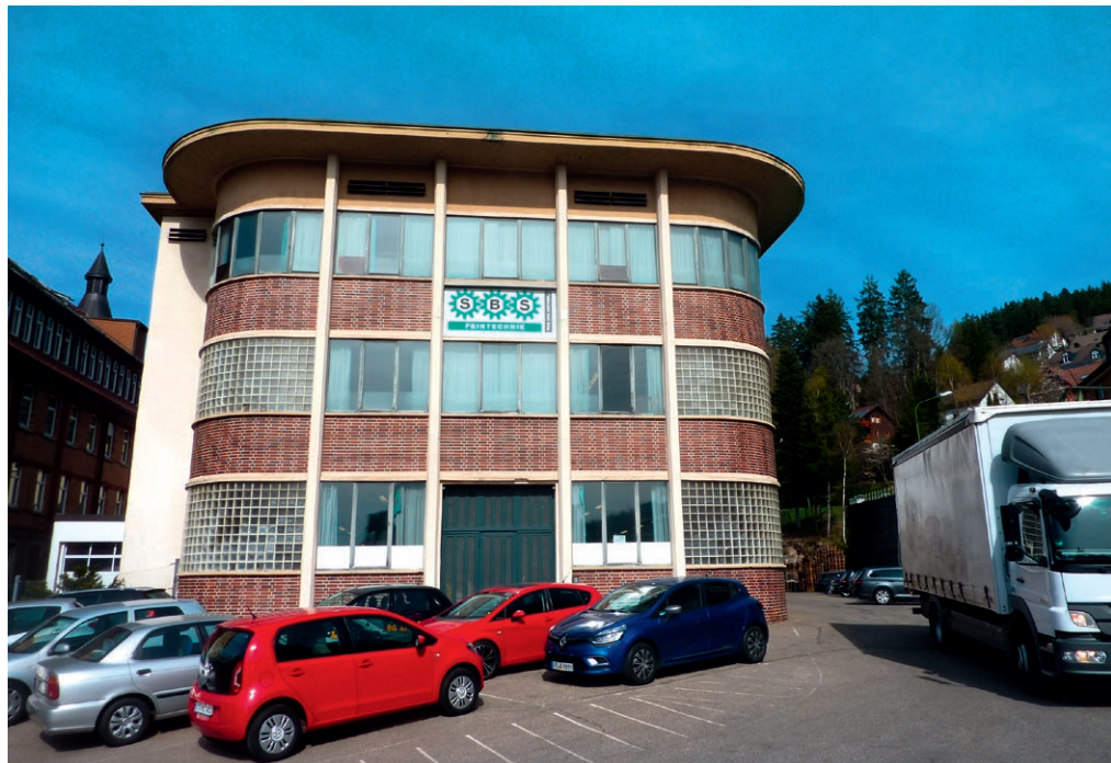
Ein deutlich überkragendes Flachdach sowie Fensterbänder unterbrochen von Backsteinmauern prägen den Industriebau.
