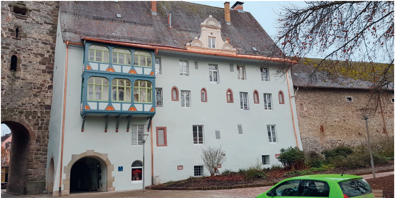
Villingen, Obere Straße, „Zeughaus“.
