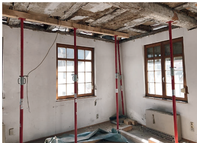
Eckzimmer im 2. Stock während der Renovierung.
