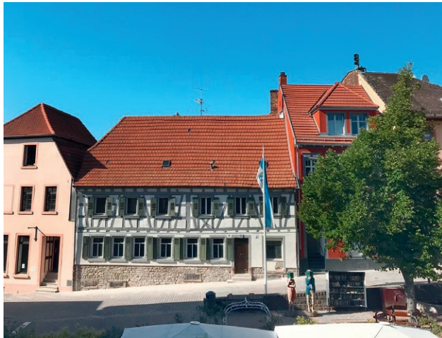
Wiesloch, Wohnhaus Marktstraße.
