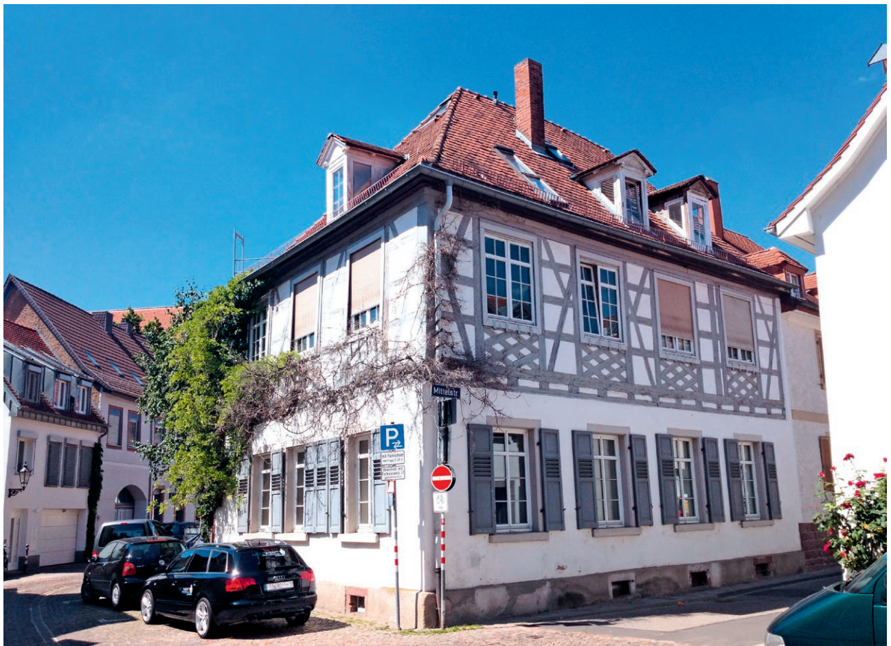
Außen noch durchaus ansehnlich, innen so marode, dass der Abriss drohte.
