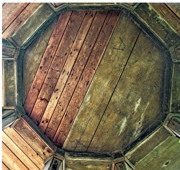
Diese feine oktogone Holzkonstruktion überdachte das Belvedere. Der Blick von hier geht hinüber zum Schloss Kirchberg (siehe Bild S. 1).
