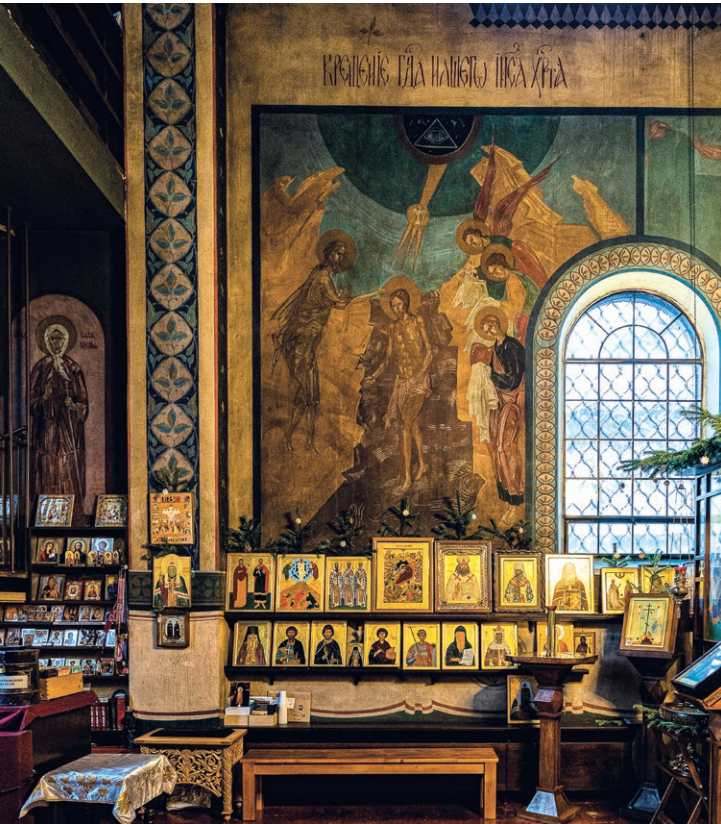
Auch die Wandgemälde im Gemeindebereich der Kirche, hier die Taufe Christi, bedürfen der Restaurierung.
