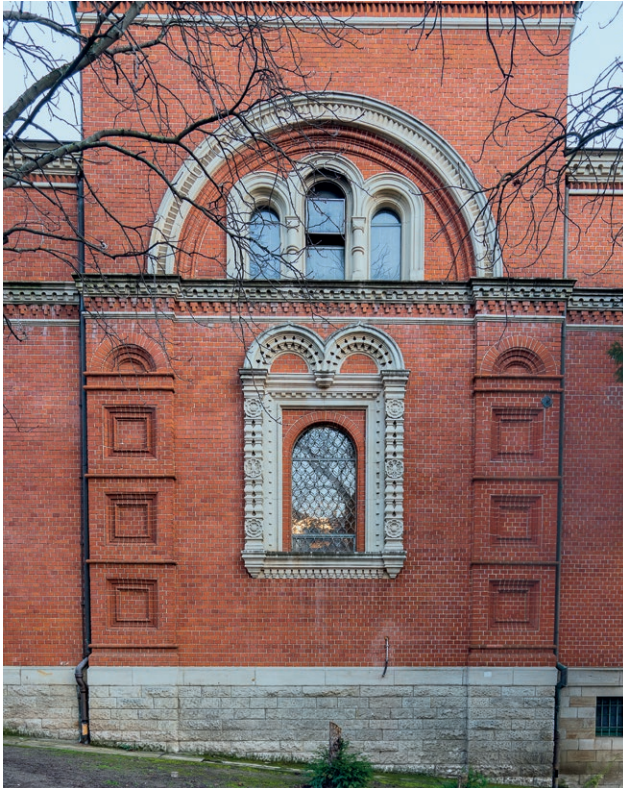
Die Architekten (Eisenlohr und Weigle) haben an den Außenfassaden nicht mit Zierelementen gespart.
