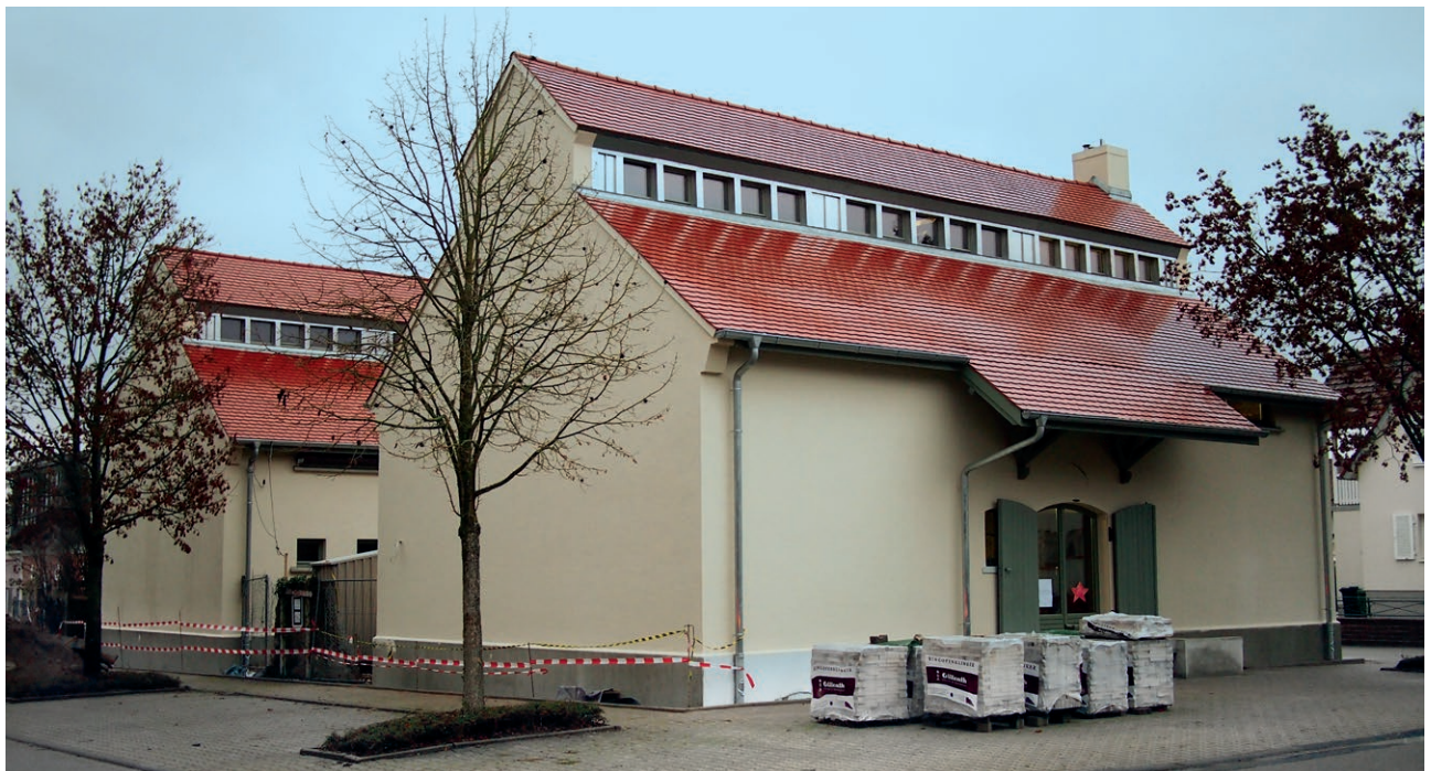
Die renovierten Tabakscheuern biberschwanzgedeckt mit markanter Fensterzeile unter dem First.
