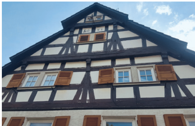
Sulz-Bergfelden, Bergfelder Hauptstraße.
