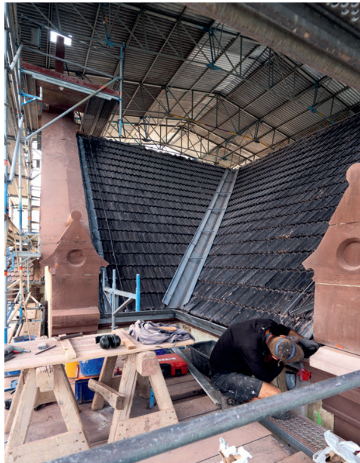
Die Dachdeckung konnte zu großen Teilen mit den ursprünglichen Ziegeln hergerichtet werden.
