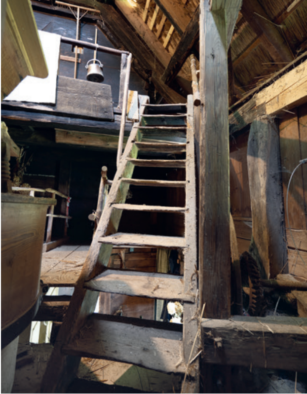
Vom Mahlgerät führt diese offene Treppe in das Dachgeschoss mit Vorratsräumen und Kammern.
