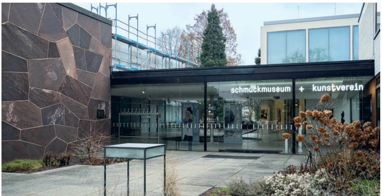
Eingang zum Reuchlinhaus; eingerüstet das ursprüngliche Schmuckmuseum links.
