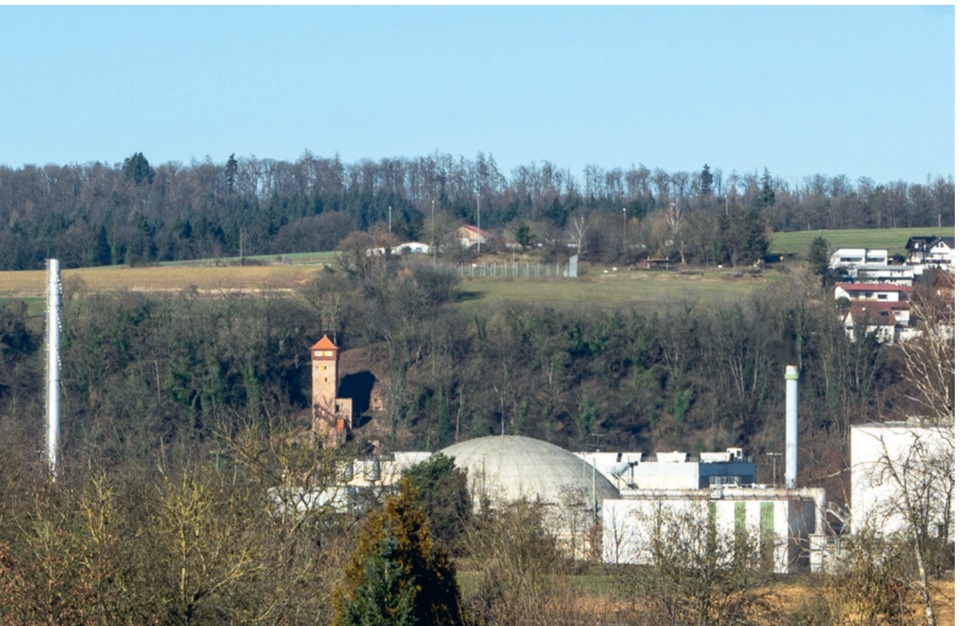
Moderne versus Mittelalter: Die Burg Dauchstein bleibt, das Kernkraftwerk Obrigheim ist stillgelegt und wird rückgebaut.
