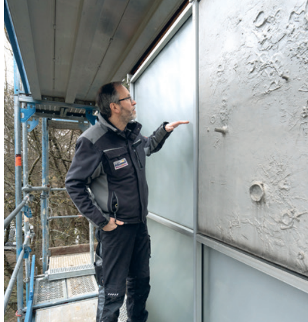
Dipl.-Ing. Reinhard Wahl beim Erläutern von Details der hochwertigen Glasmodule, die erneuert werden mussten.
