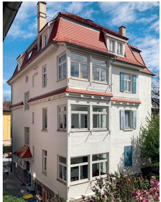
Reutlingen, Charlottenstr. 42, Mehrfamilienhaus.
