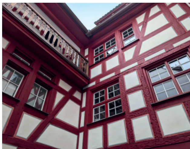
Im Innenhof des Fachwerkkomplexes Büchsen­gasse 12.
