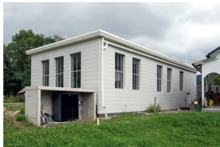
Die erneuerte Rückseite des zukünftigen Wohnbaus, schon mit Wärmepumpe.
