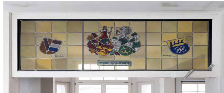
Aufwendige Glasfenster der Innenausstattung aus dem 20. Jahrhundert werden erhalten.
