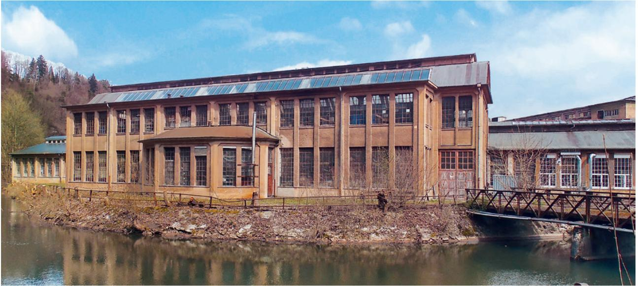
Ein wichtiger Teil der ehemaligen Rottweiler Pulverfabrik: Die grandiose Stahlbetonkonstruktion des Werkstattbaus von 1915/16 erinnert mit Haupt- und Seitenschiffen an eine Basilika.
