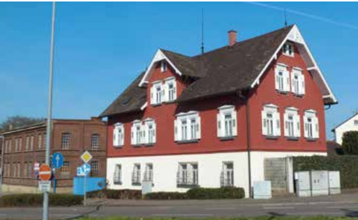
Bietigheim-Bissingen, LB, Elbe-Villa
