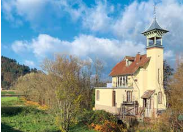
Gengenbach, OG, Reichenbacher Turbinenstation
