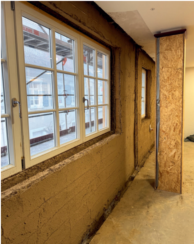
Verputzen der Wandheizung im Inneren. Hier entstehen die neuen Verkaufsräume.
