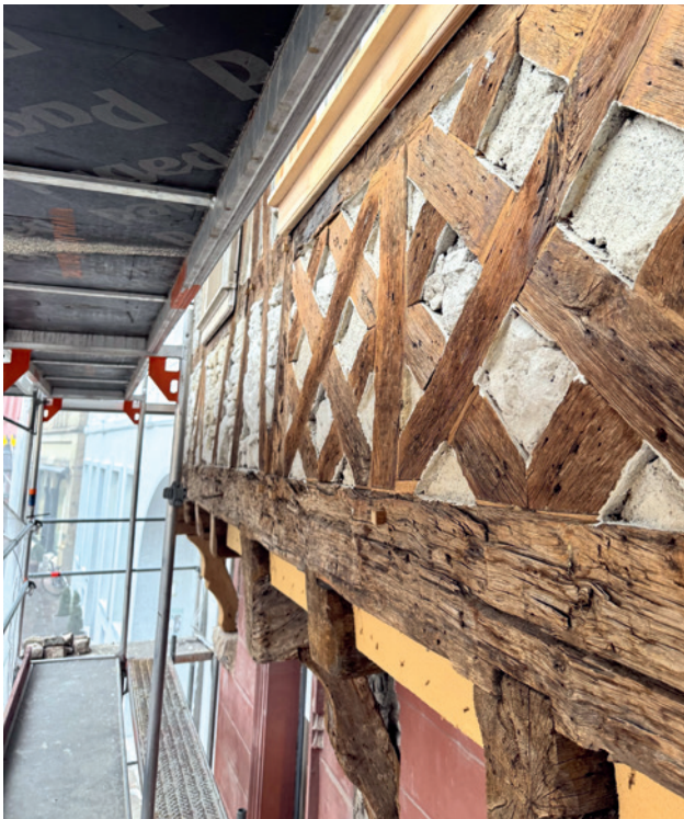
Gerüst am freigelegten Fachwerk.
