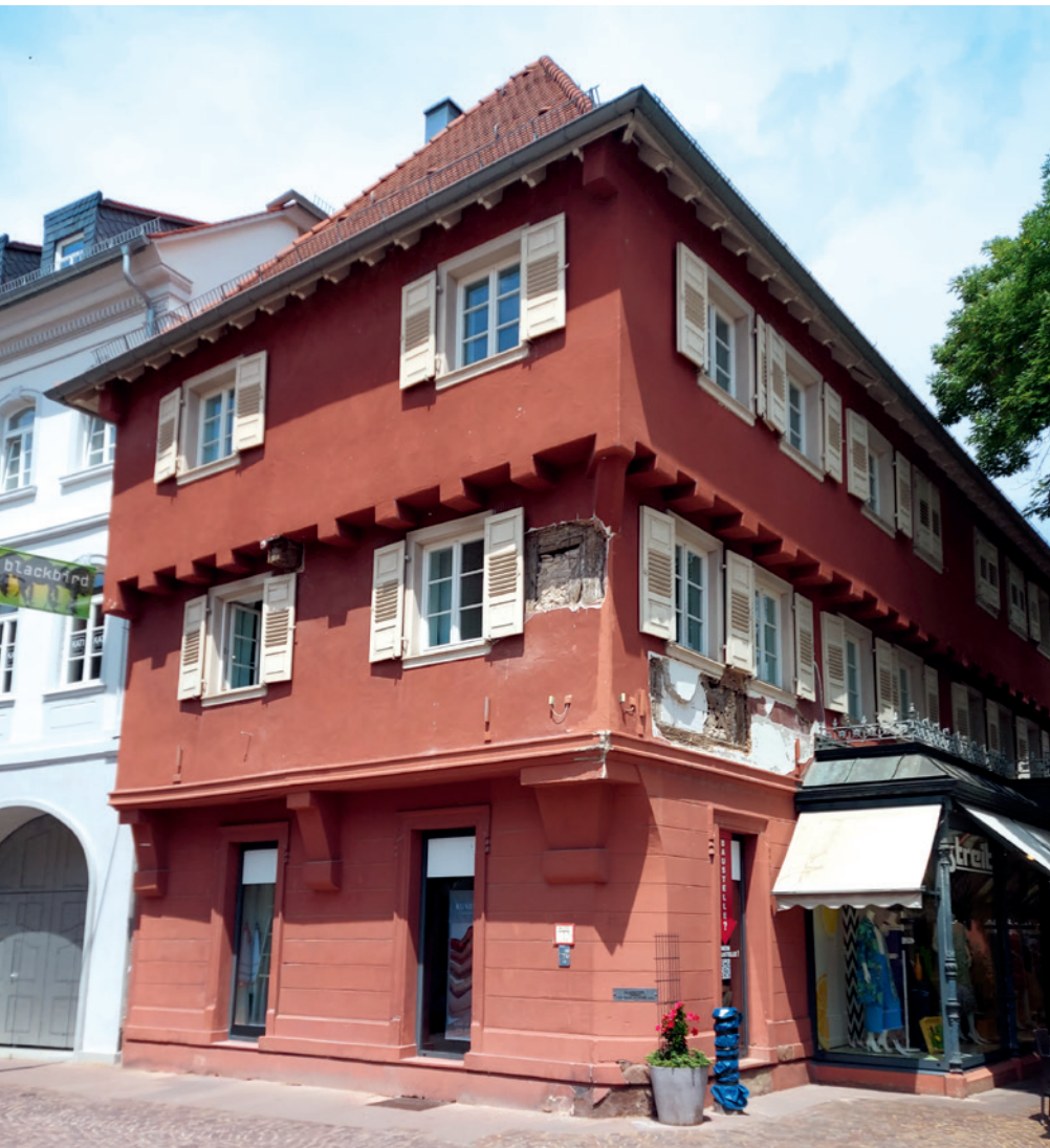
Der Zustand des Kaufhauses Streit in Ettlingen vor der Sanierung, hier noch mit Klappläden im 1. OG.
