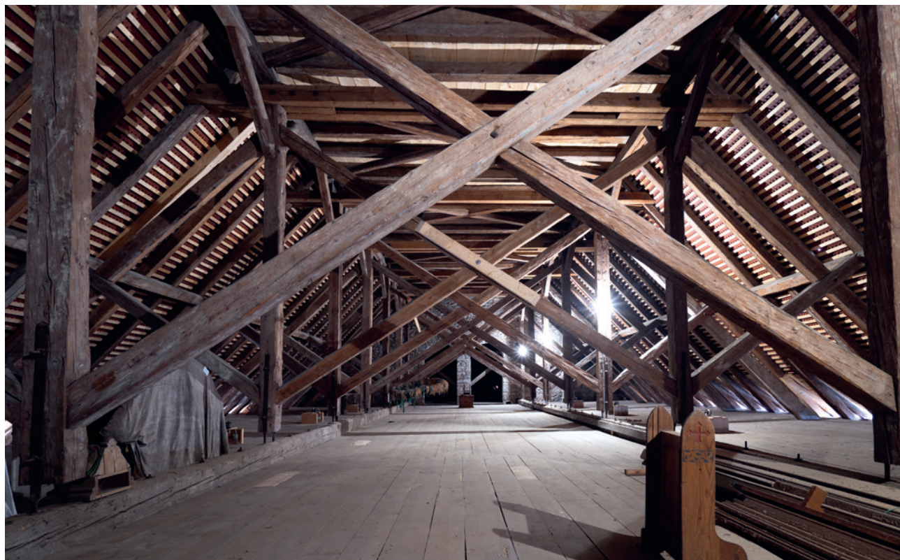
Innenansicht der Dachkonstruktion nach ihrer Sanierung.
