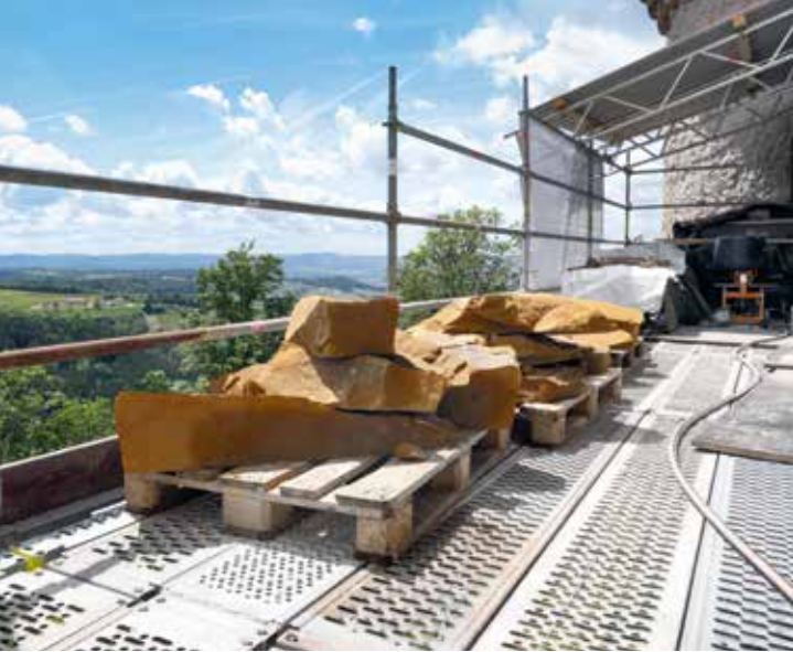
Farblich passende Austauschblöcke aus Jurasandstein.
