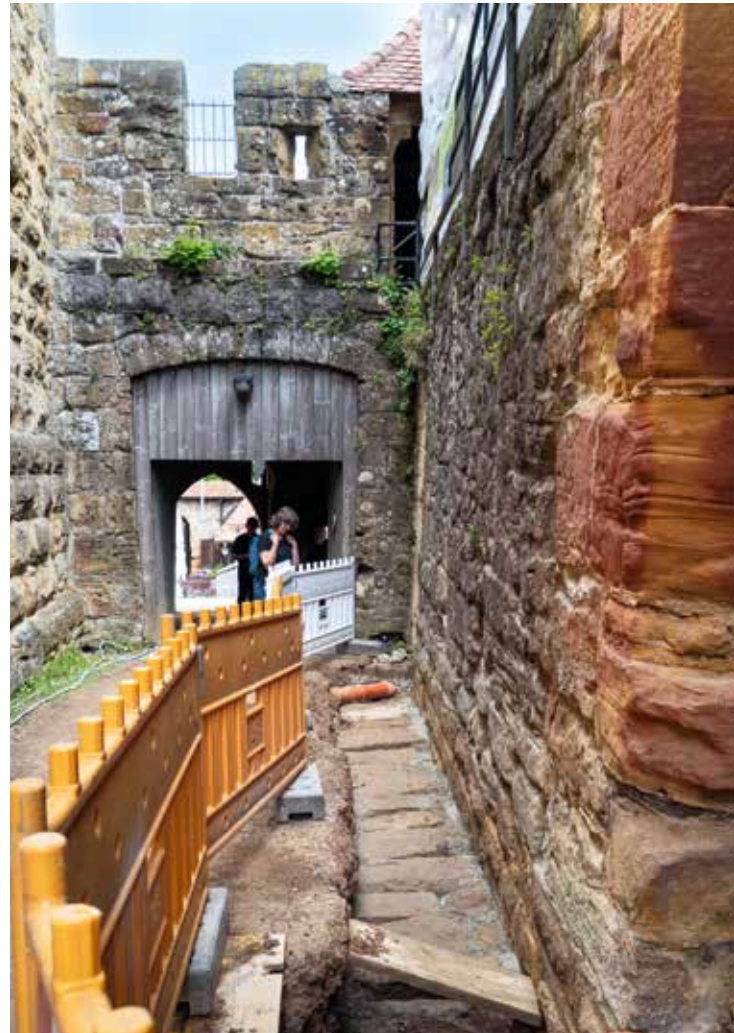
Unerwartete Entdeckung: der historische Entwässerungskanal.
