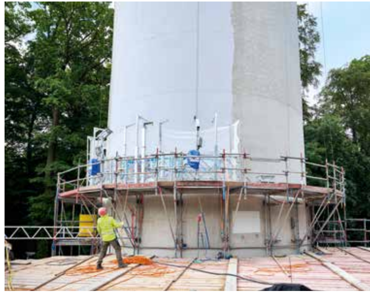
Die eigens konstruierten Arbeitsbühnen in ihrer Grundposition.
