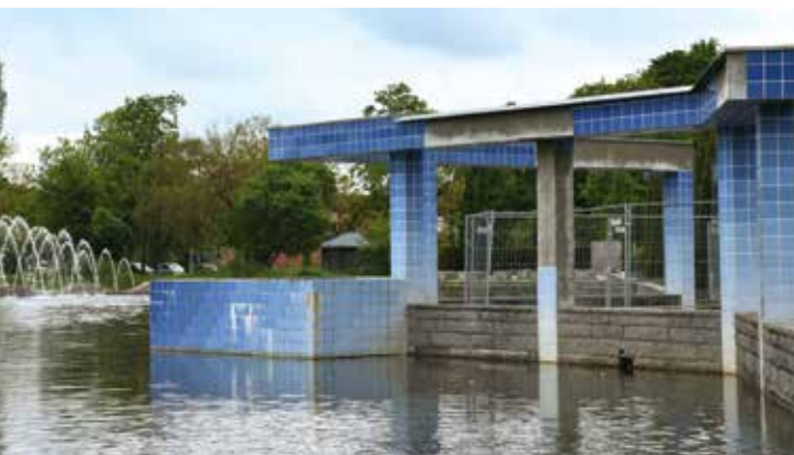
Zustand während der Sanierungsarbeiten – heute ist alles wieder zugänglich.
