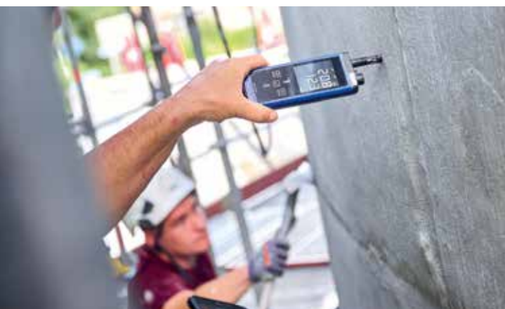
Für die Farbapplikation werden mittels Messgerät unter anderem Luftfeuchtigkeit und Objekttemperatur gemessen.
