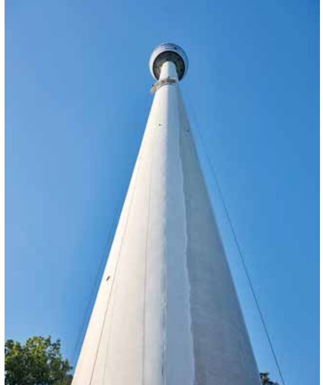
Froschperspektive auf den Turmkorb während der Sanierung.
