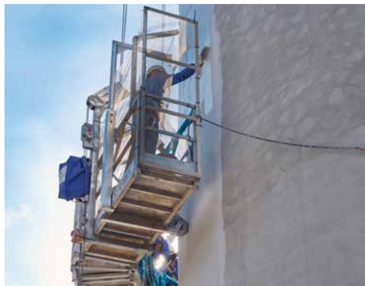
Nicht ohne: Sanierungsarbeiten in luftiger Höhe.
