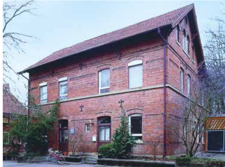
Ludwigsburg, LB, Auf der Karlshöhe 9, Back- und Waschhaus.
