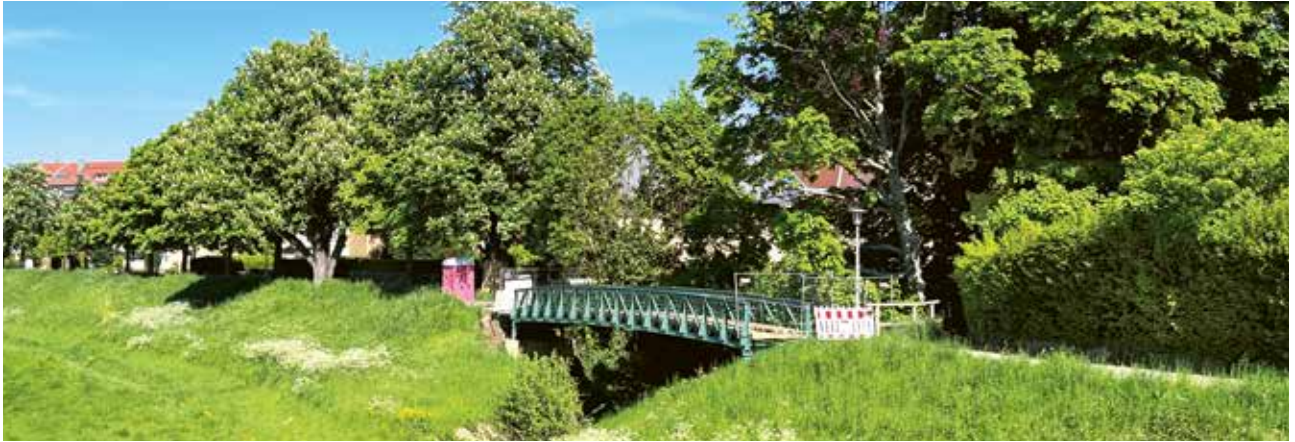
Rastatt, RA, Fußgängerbrücke über den Schachtelbach.
